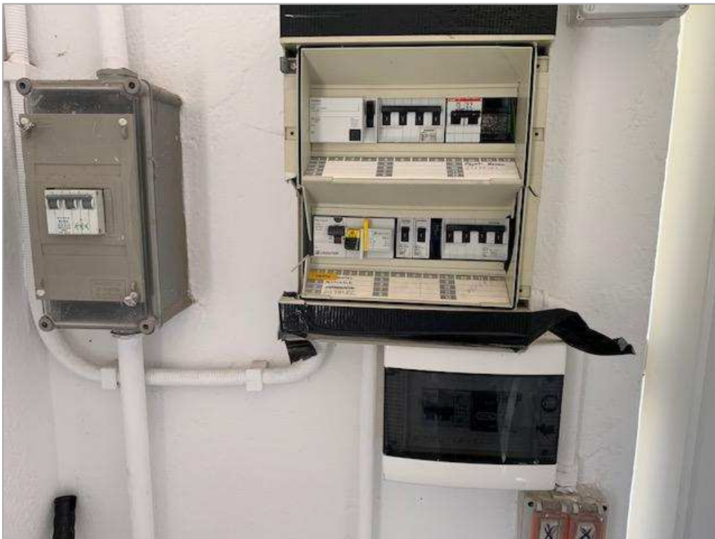
Cuadro de fuerza existente de la caseta de aforos a sustituir
